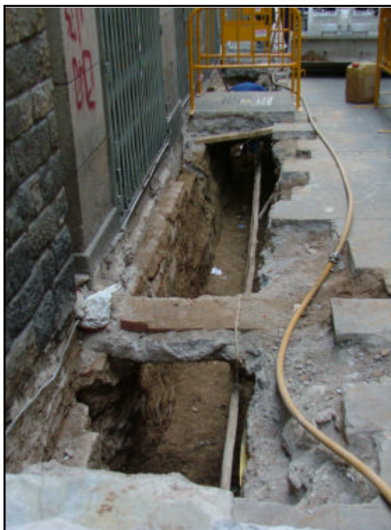
Foto 4.- Vista general del primer tram de la rasa 1.
