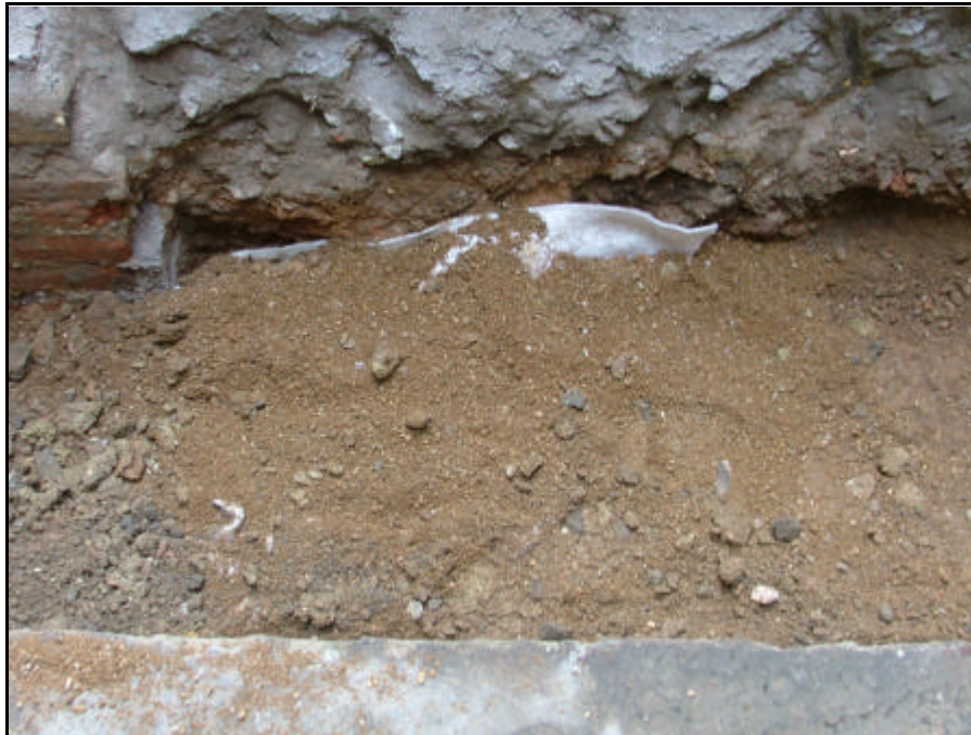
Foto 30.- Estructura UE 110 protegida amb geotèxtil i sauló.
