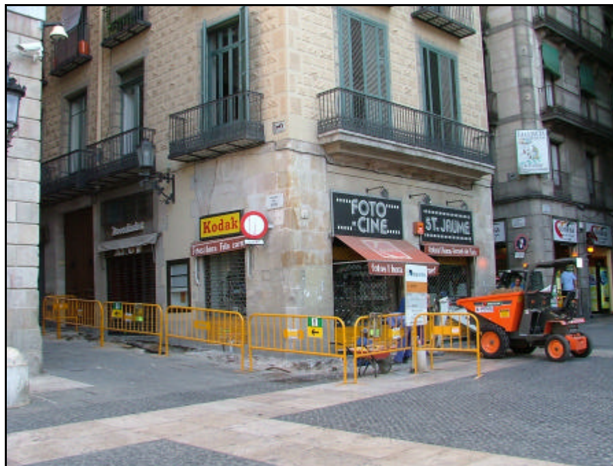
Foto 19.- Vista general de la situació de la rasa 2.
