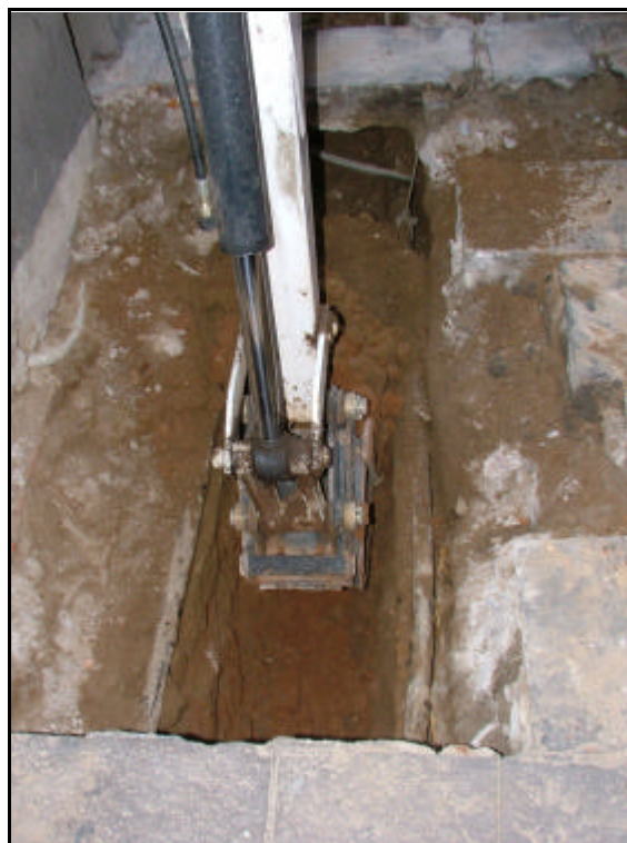
Foto 6.- Vista de detall del segon tram de la rasa 1 amb l'UE 104.
