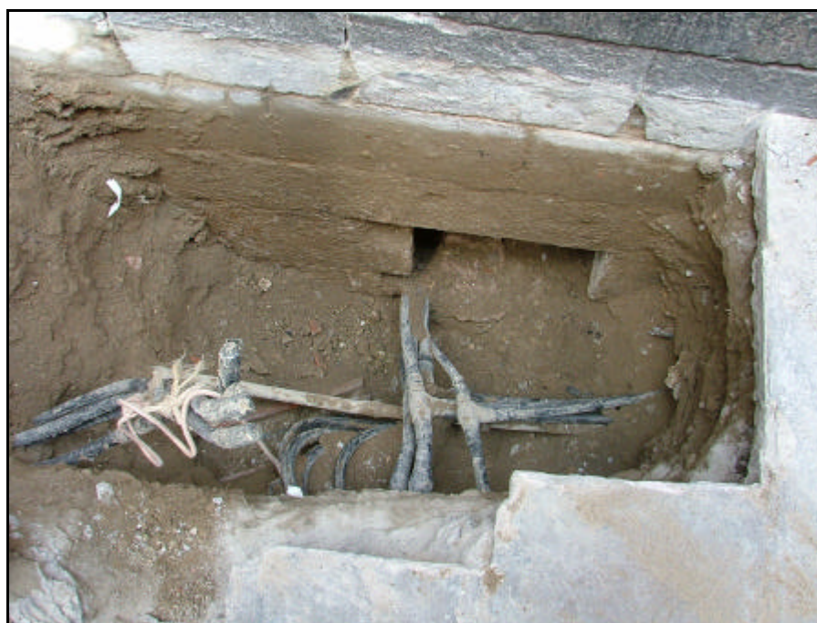
Foto 26.- Mur de fonamentació de la catedral. Obertura preexistent per accedir a l'ET.
