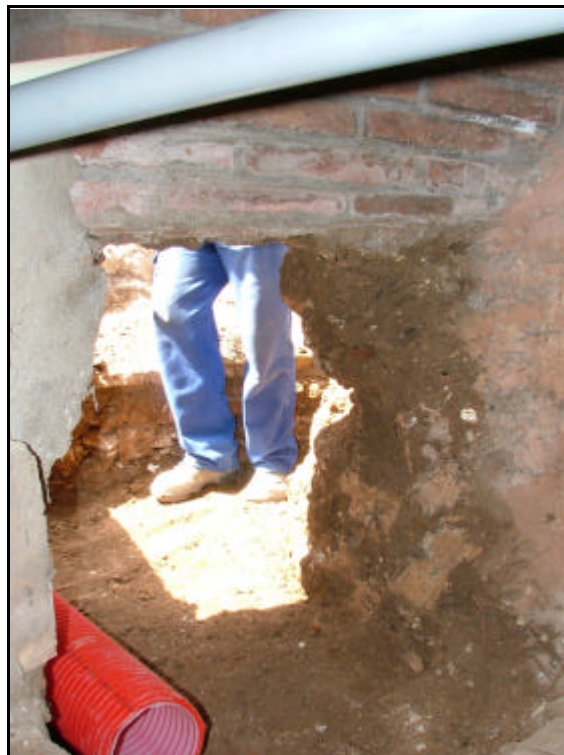
Foto 13.- Canalització dels tubs cap a l'interior de la casa del Canonges.
