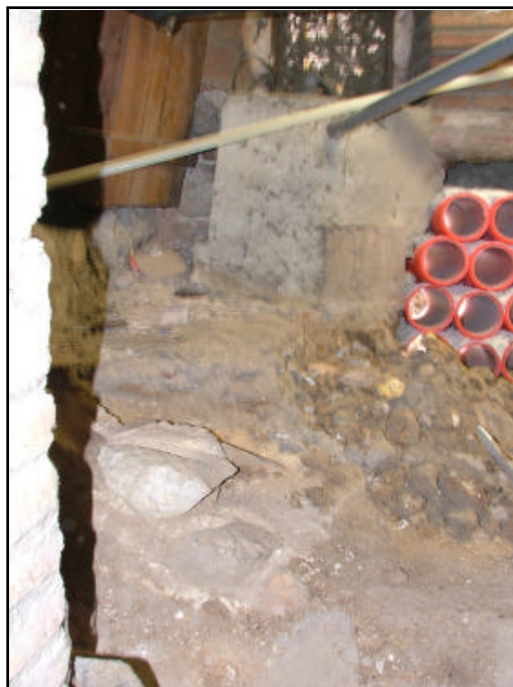
Foto 14.- Nivell UE 106 al fons i estructura UE 107 en primer plànol.
