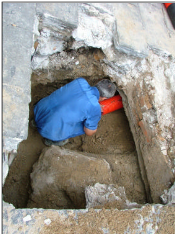
Foto 23.- Vista de detall de la rasa 4.
