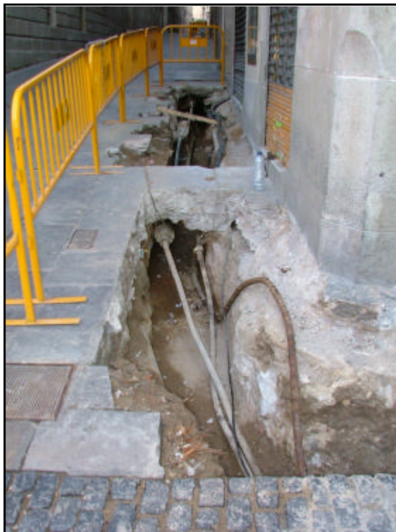
Foto 7.- Vista general del tercer tram de la rasa 1.
