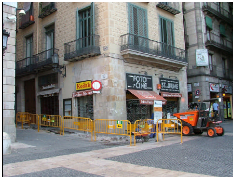
Foto 19.- Vista general de la situació de la rasa 2.
