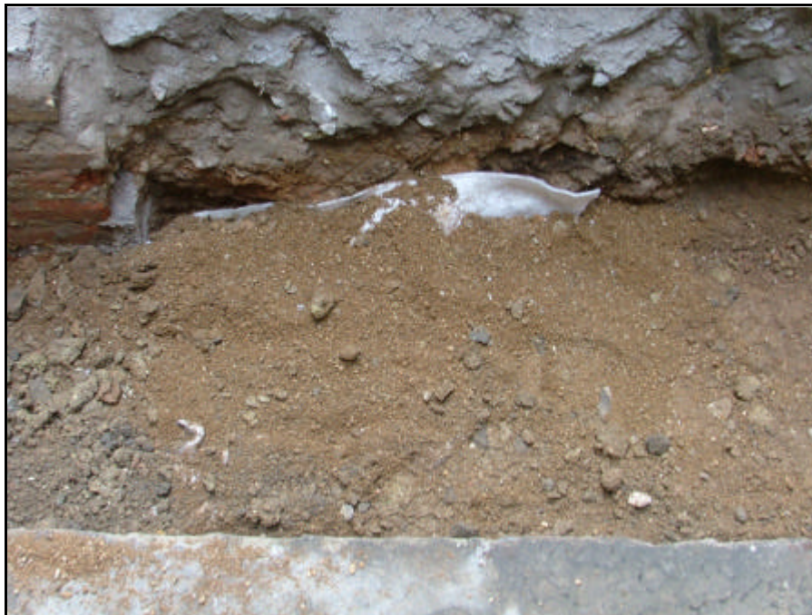
Foto 30.- Estructura UE 110 protegida amb geotèxtil i sauló.
