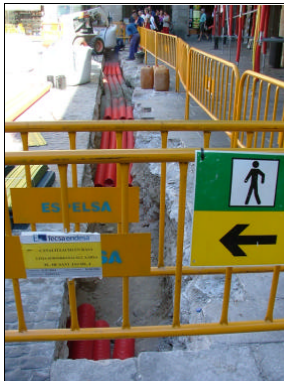
Foto 22.- Vista general de la rasa 2 amb la col·locació dels tubs.
