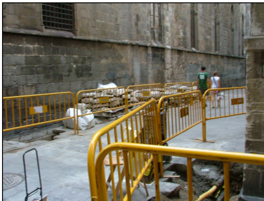
Foto 25.- Vista general de la situació de la rasa 5.
