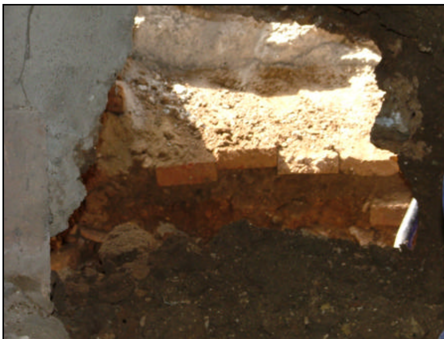
Foto 12.- Detall de l'obertura preexistent al mur de fonamentació de la casa dels Canonges.
